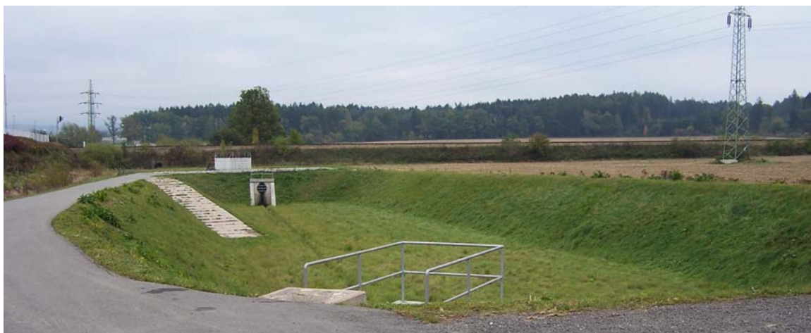
Průchod VVN 110 kV a jeho ochranného pásma západním okrajem plochy Z8-1 (T2)
