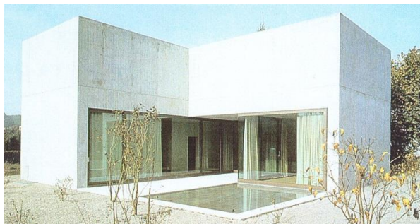
RD s rovnou střechou
