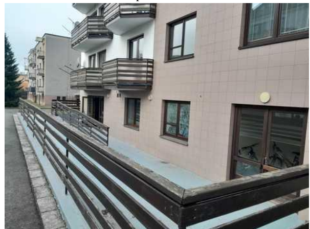
přístup k nebytové jednotce od J
